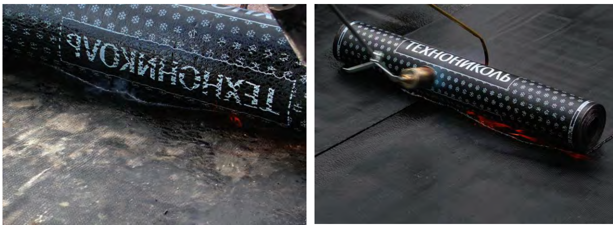
Рис. 5. Валик расплавленного битумно-полимерного вяжущего
