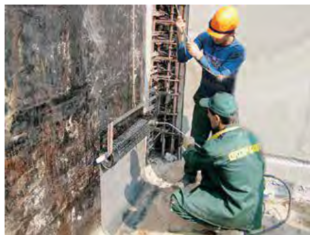
Рис. 9. Подача рулона с помощью лебедки при устройстве вертикальной гидроизоляции
