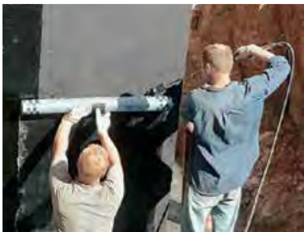
Рис. 8. Ручная подача рулона при устройстве вертикальной гидроизоляции
